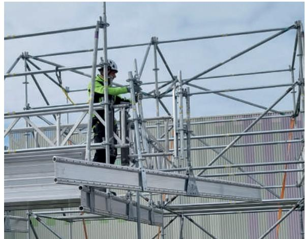
Anschließend kann der Träger sicher gedreht und für das Einhängen der Beläge vorbereitet werden.
