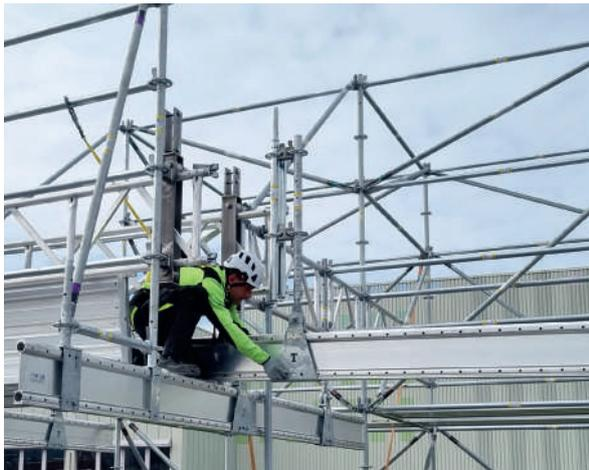
Zu Beginn wird der nächste Brückenträger eingehängt.
