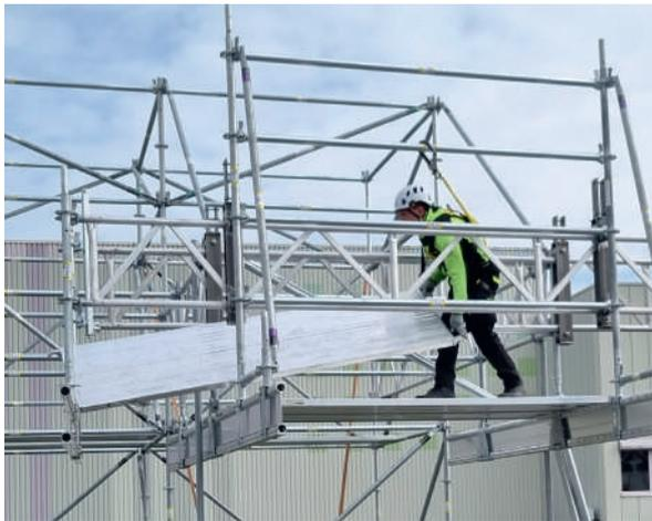
Als vorletzter Schritt werden die Beläge auf den Brückenträger gelegt.
