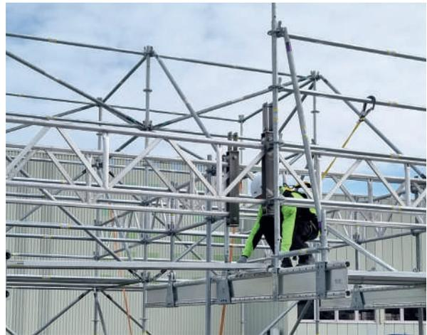
Abschliessend wird mit Hilfe des Belags der Brückenträger an seiner neuen Position fixiert.
