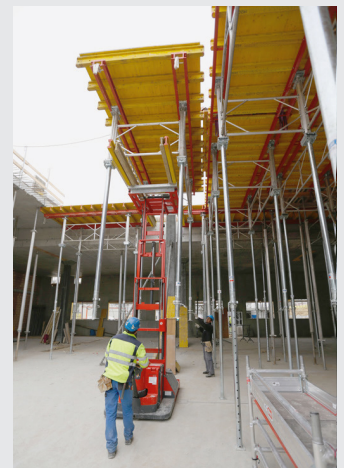
Wirtschaftliches Umsetzen mit batteriebetriebenen Kart durch 1 Person.
