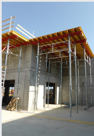
Unterstellt mit Deckenstützen bis zu einer Geschosshöhe von 7,25 m.
