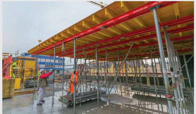
Lediglich 4 Deckenstützen bis Deckenstärke 40 cm.
