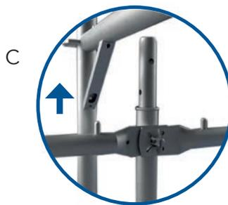
3. Posizionamento del telaio ad H con i puntoni parapetto superiori (D)
