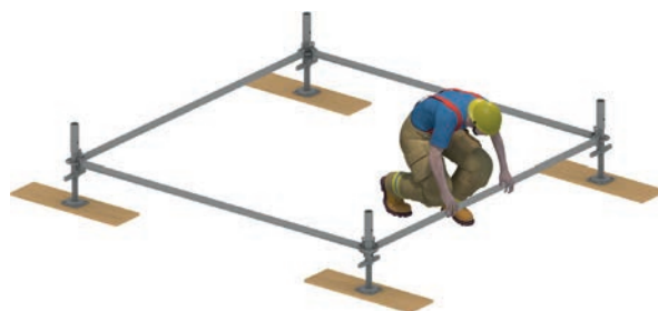
Figure 45 : Montage du châssis de base pour l'échafaudage à chevalet.
