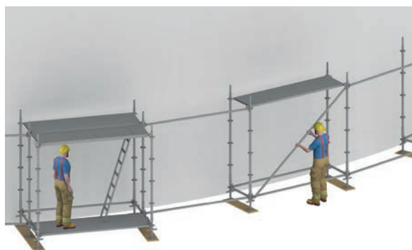
Figure 55 : Montage des diagonales verticales
