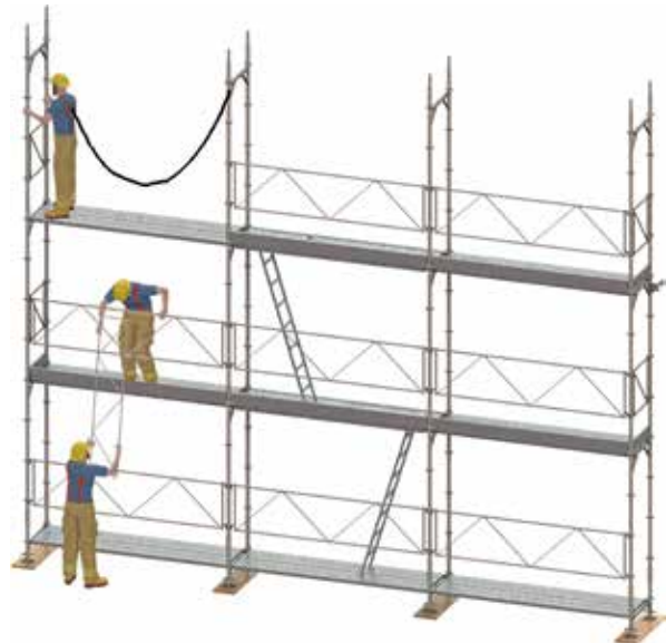
Bild 20: Beispiel für die Montage im Schutze der PSAgA auf der obersten Gerüstlage
