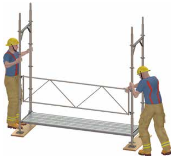
Bild 3: Aufbau des ersten Gerüstfelds
