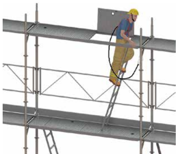
Bild 21: Sicherung mit der PSAgA vor dem Betreten der obersten Gerüstlage
