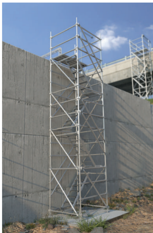
Torre scala per l'accesso al cantiere
