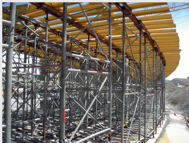
Traggerüst bei Kunstbauten im Strassenbau sowie Bahnverkehr
