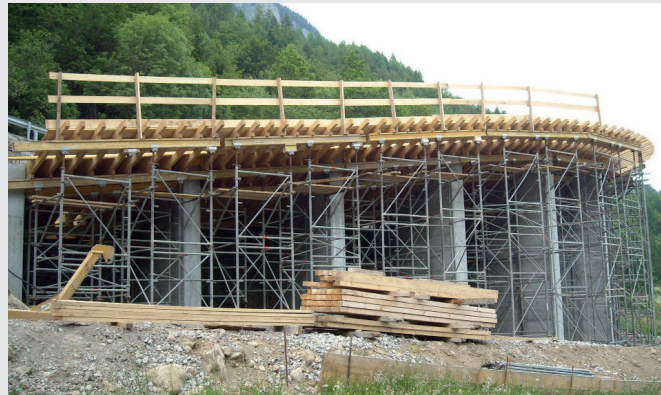
Flexibles Traggerüst für komplexe Geometrien Anpassungsfähig an Längs- und Quergefälle
