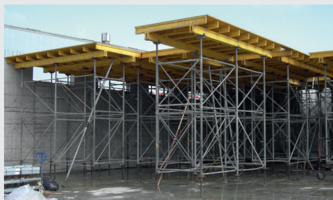
Spriessgerüst ck-22 unter Deckentische, horizontal verfahrbar
